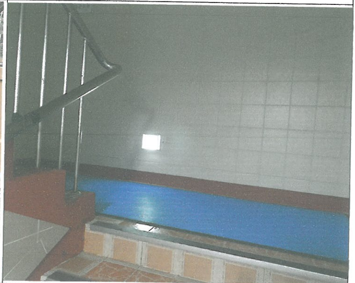
수영장 여자 샤워장 계단 통로 유도등 점등 불량 1개소 교체
