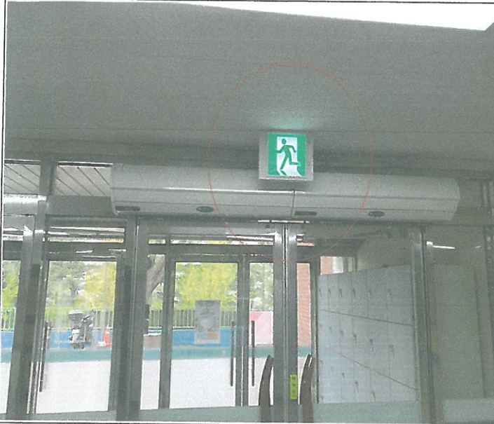
1층 주 출입문 피난 유도등 중형 1개소 설치
