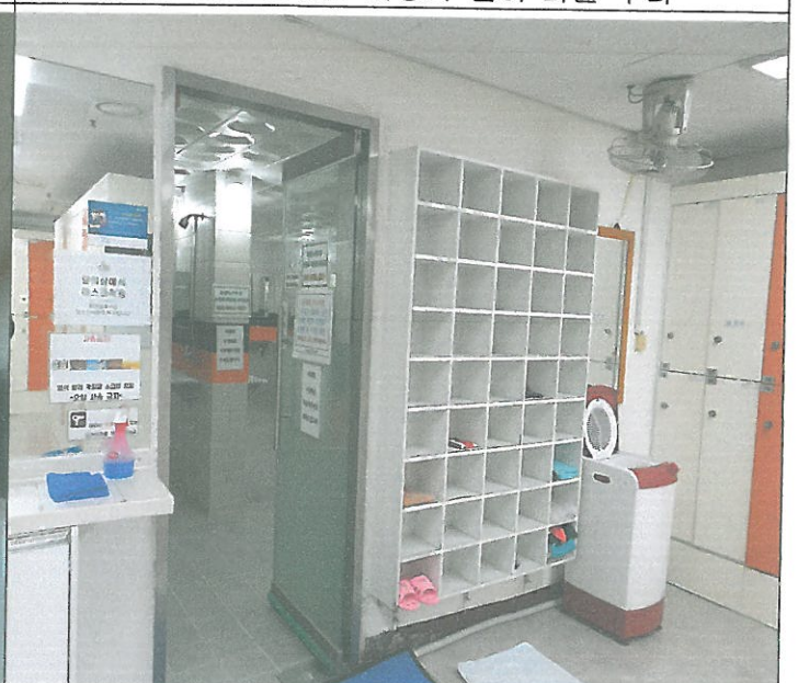
수영장 여자 샤워실 출입 강화문 이동설치 작업
