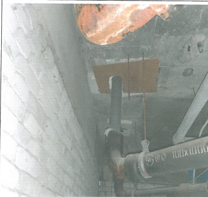
3층 여자 화장실 대변기 오수 배관 누수 조치
