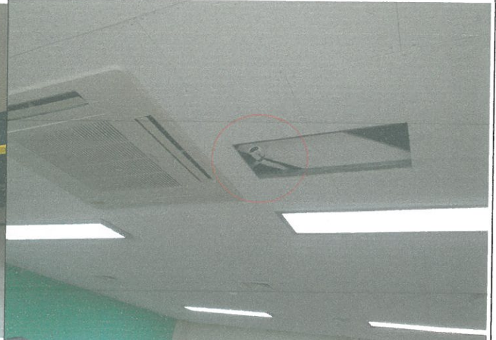
다목적실 에어컨 전선배관 실리콘 마감
