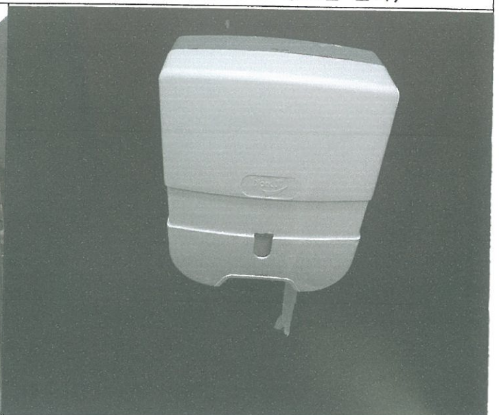
1층 여자 화장실 화장지 걸이 파손 수리
