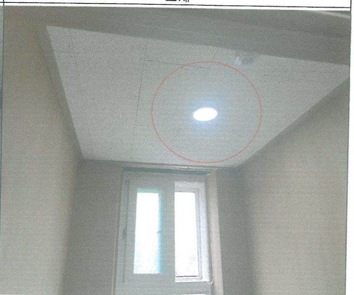
3층 아마데우스 실 3번 방 천장 다운라이트 점등 불량 1교소 교체
