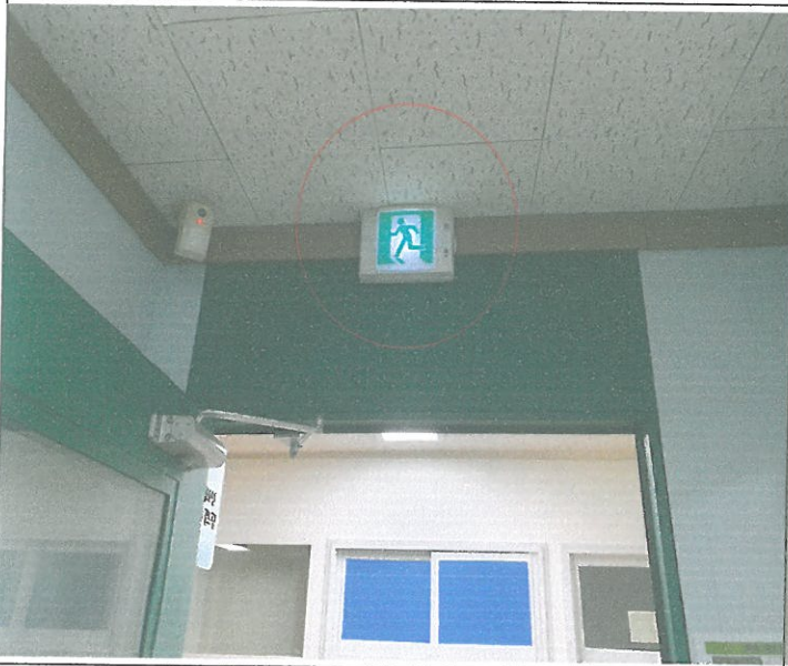
2층 강남구청 상담복지 센터 피난유도 등 소형 점등 불량 1개소 교체
