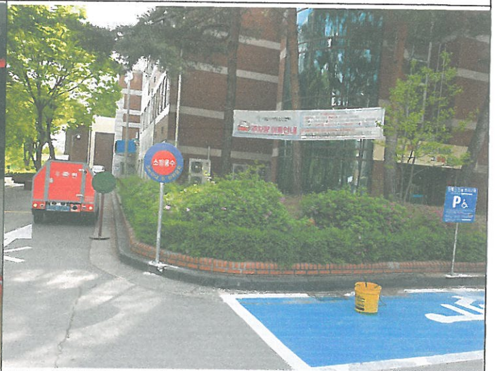
옥외 소화전 소방용수 표지 설치
