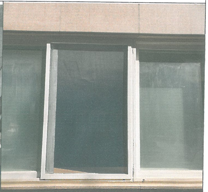
유스룸 샤시 방충망 1기 보수 설치
