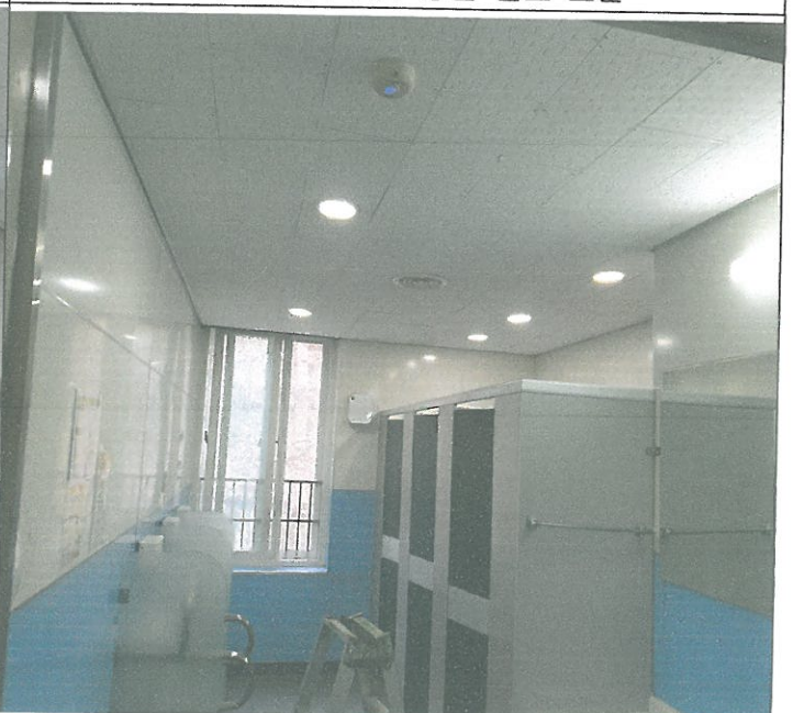
2층 남자 화장실 천장 다운라이트 조도가 낮음 전체 교체
