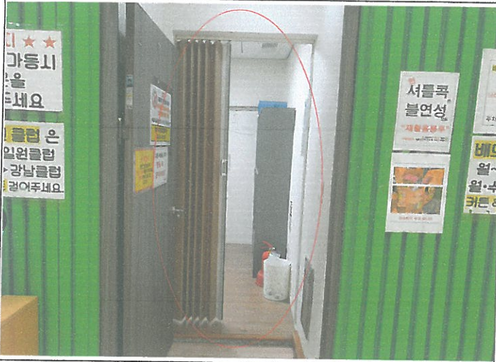
대체육관 남자 샤워실 출입 자바라 문 탈락 보수
