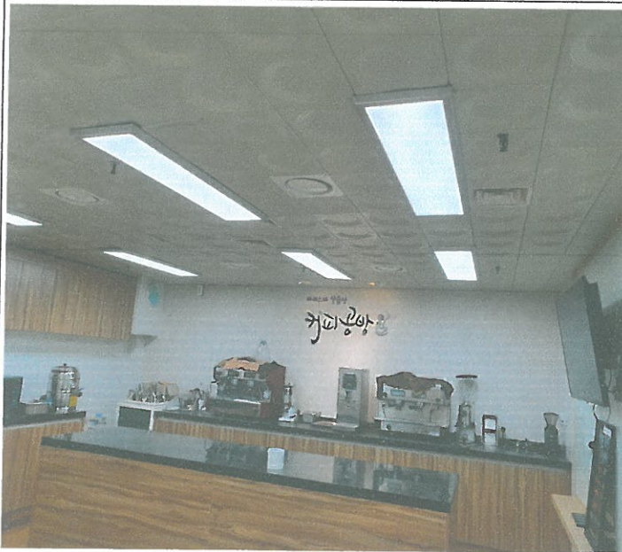
지하 1층 커피공방 천장 훼손 개소 보수
